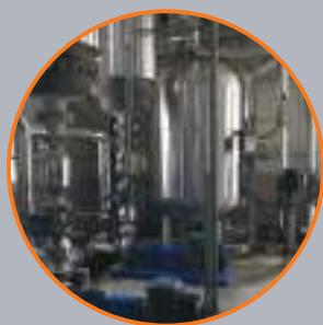
Резервуар Process Tank
